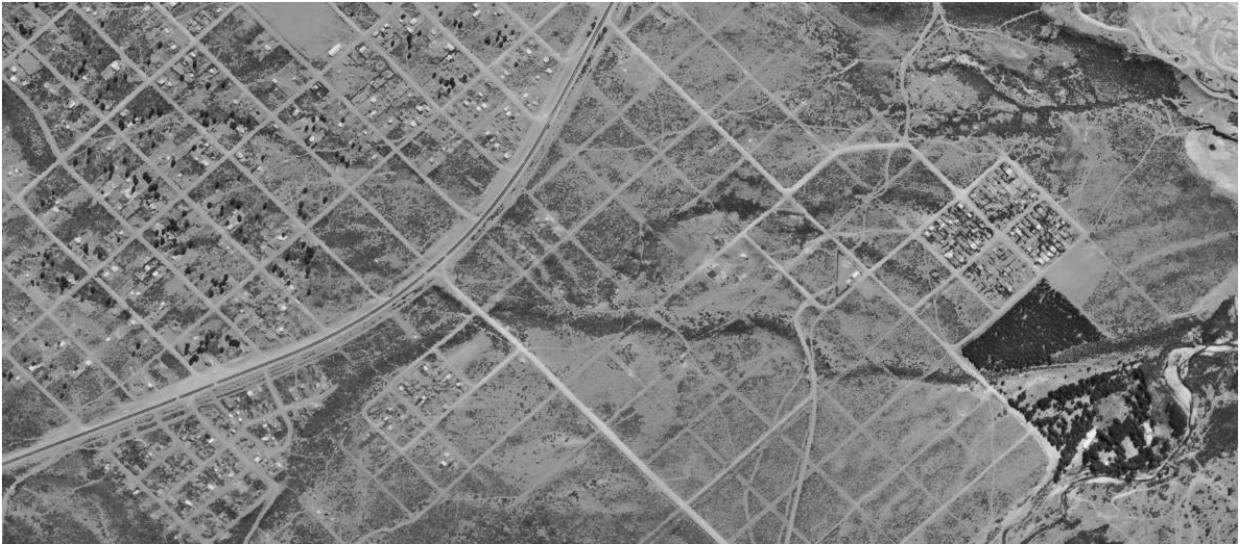
FIGURA.2 – SALIDA DE AGUAS PLUVIALES DE B° EL FRUTILLAR CRUZANDO LA RN 258 Y DESCARGANDO SOBRE EL B° NUESTRAS
